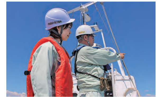
海上の施工箇所を船上から確認
