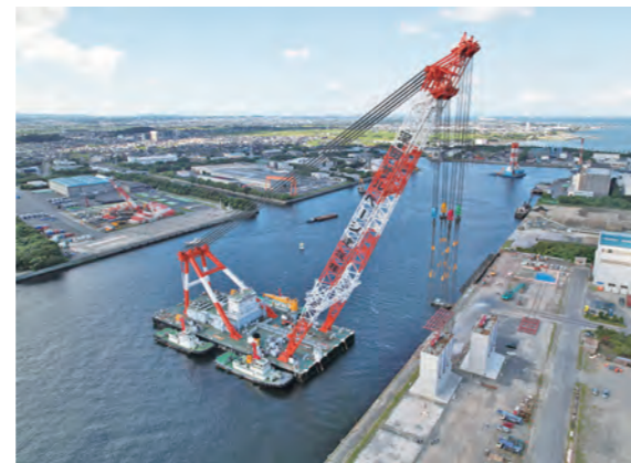
ケーソン据付準備(吊降し方式)状況
