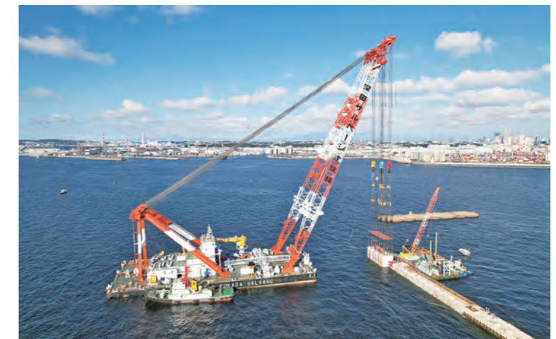
現地でのケーソン据付状況
