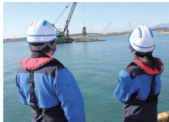
ケーソンへの中詰め作業が進む現場を臨む
