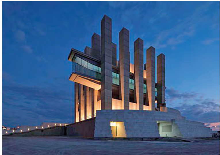
那覇沈埋トンネルの換気塔
