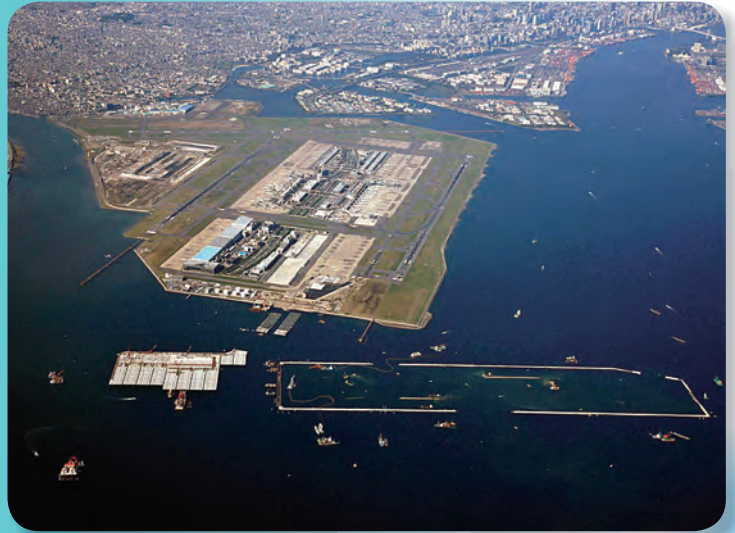
埋立部外周護岸の捨石マウンドが概成
