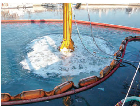
写真-2 ジェット噴射状況
