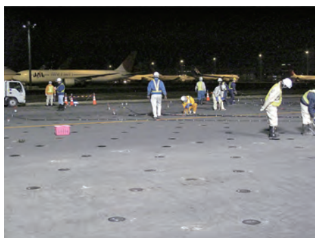
写真-1 東京空港 J3 誘導路の施工状況
