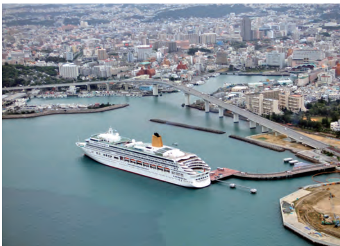
暫定供用したクルーズ船専用ターミナル
