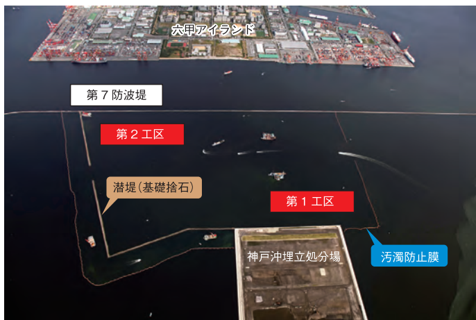
神戸港六甲アイランド地区航路・泊地(-15m)等(RC-7)浚渫(附帯施設)工事の施工場所
