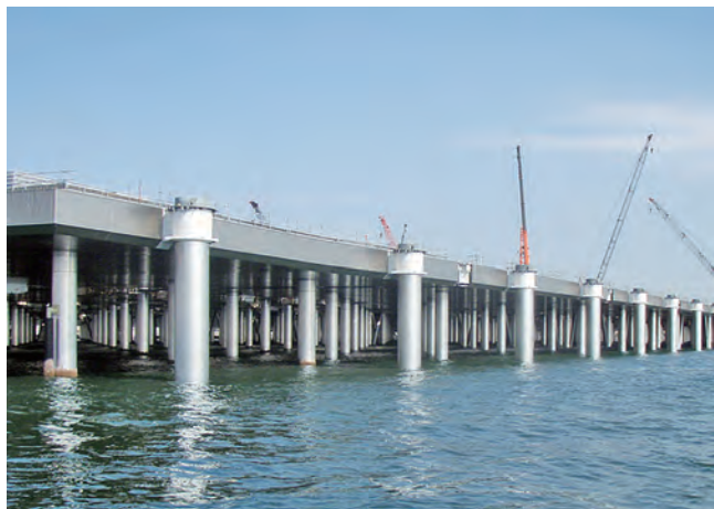
栈橋部での工事
