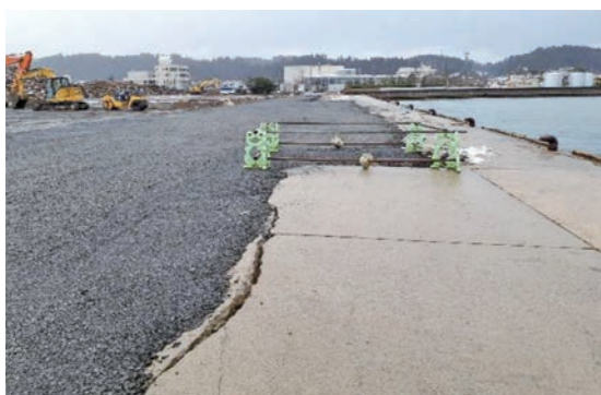
応急復旧後の状況（水深4.5m岸壁）
