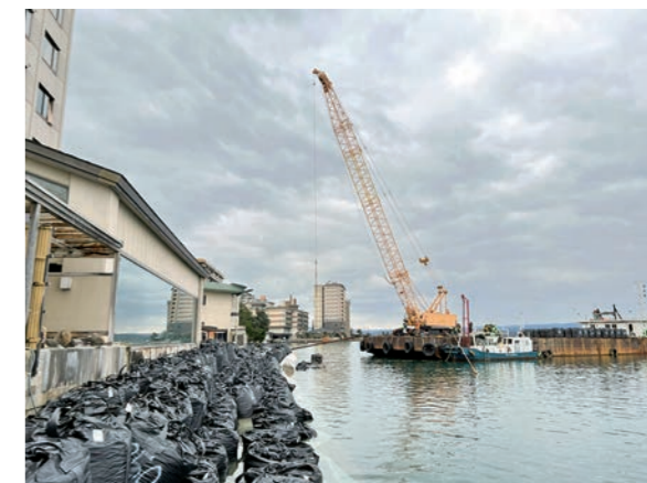
和倉港、和倉港海岸で護岸倒壊や浸食防止に対応
