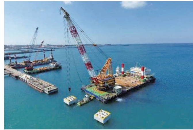
PCaブロック据付状況
