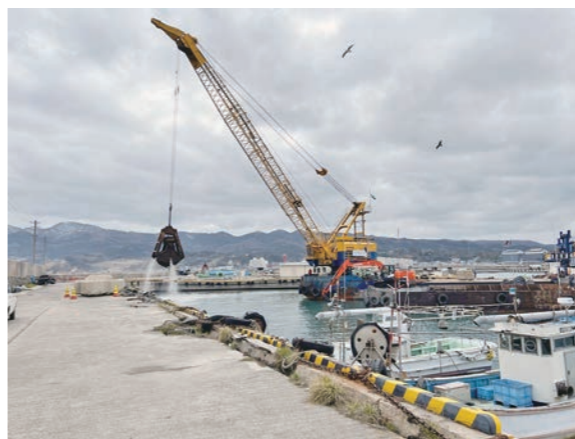
輪島港での航路啓開作業。水深を確保するための浚渫
