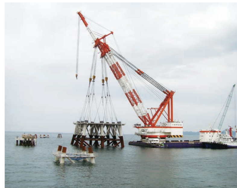
大型ジャケット据付作業
