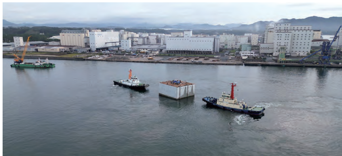
現場へケーソンを曳航
