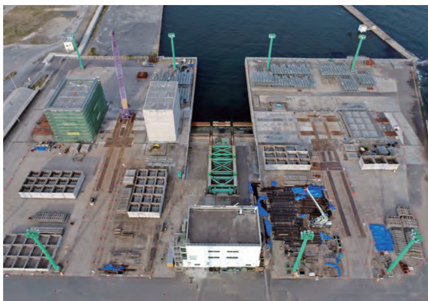
ケーソンヤード全景
