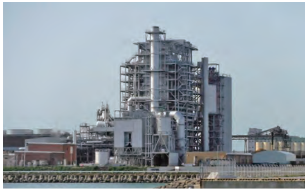
石巻ひばり野バイオマス発電所
