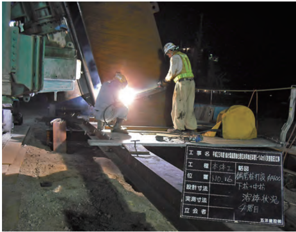
24時間3交代で工事が進められていた
