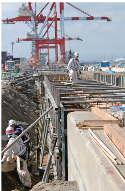
レール基礎と代替え杭を一体化して補強
