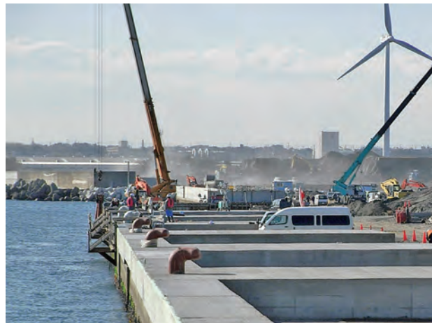
耐震強化岸壁が計画されている外港地区
