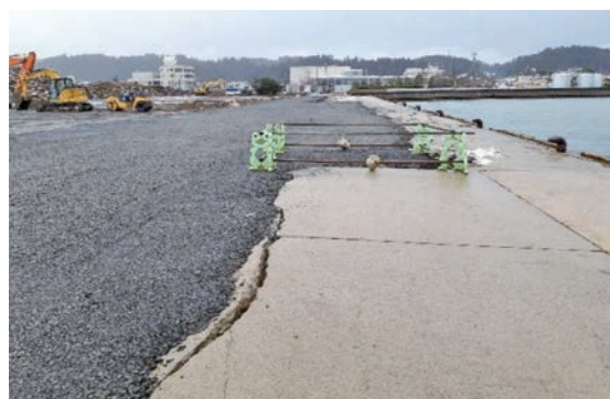
応急復旧後の状況（水深4.5m岸壁）
