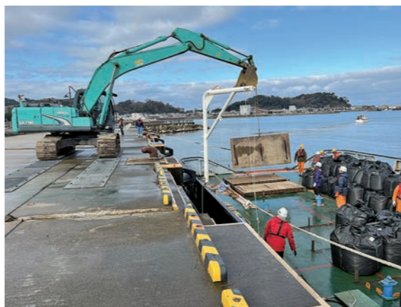
新世丸で海上輸送した敷鉄板（通路用）を輪島港で荷下ろす
