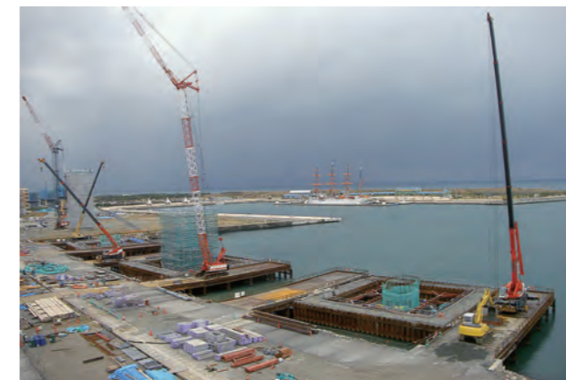
施工当時の現場の様子
