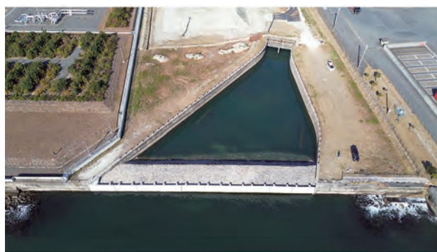
L型ブロックを据え付けた現地の状況
