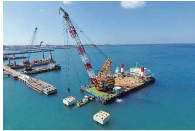
PCaブロック据付状況
